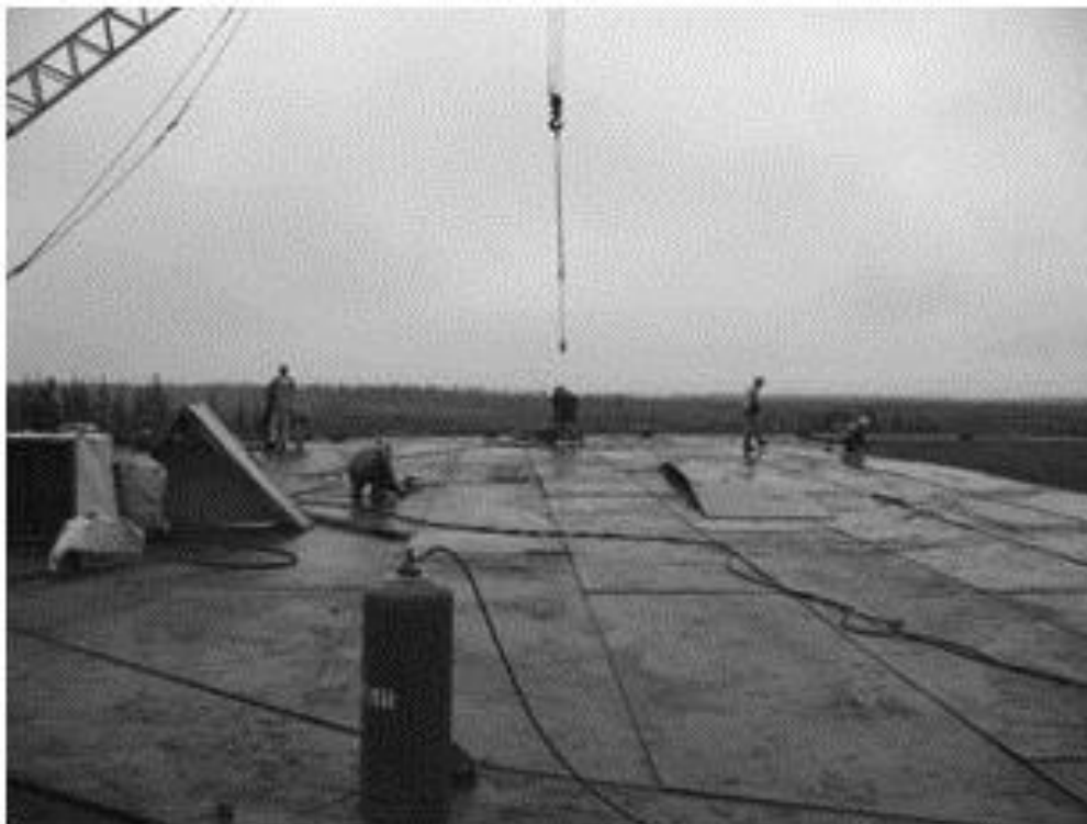
Рис. 1. Сборка и сварка основания
